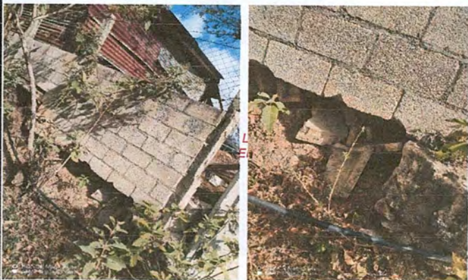
Foto 3: Mejoramiento de reparación de muro perimetral.
