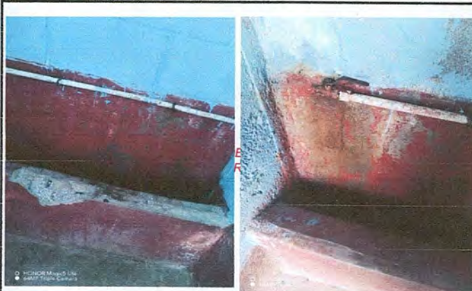
Foto 2: Mejoramiento de servicios sanitarios y sus accesorios
