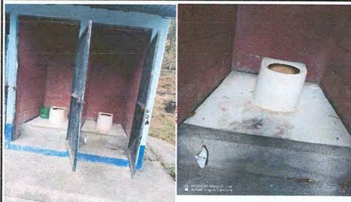
Foto 1: Mejoramiento de servicios sanitarios y sus accesorios.
