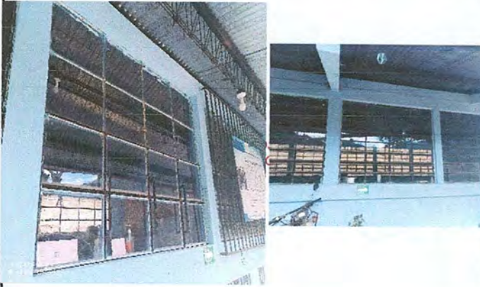
Foto 4: Mejoramiento de barandas.
